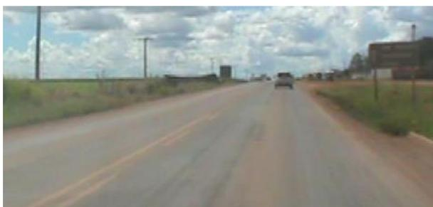
Figura 6: Trecho com pavimento e sinalização horizontal satisfatórios, sem presença de acostamento e permissão de ultrapassagem em um dos sentidos.
