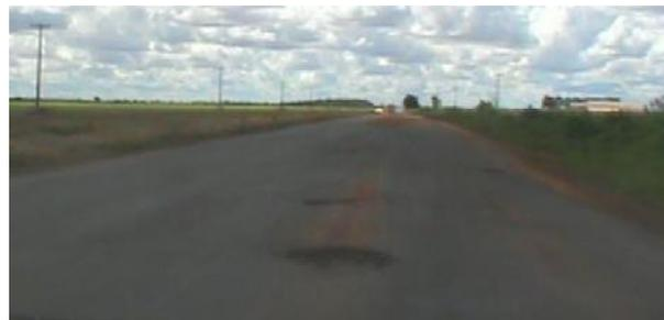
Figura 3: Trecho com pavimento carente de revitalização, e ausência de sinalização horizontal, vertical e de acostamento.
