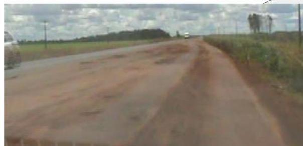
Figura 5: Trecho totalmente degradado e com ausência de sinalização horizontal e vertical.
