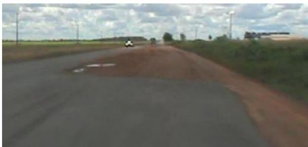
Figura 4: Trecho com interrupção de pavimento em um dos sentidos e ausência de sinalização horizontal, vertical e de acostamento.
