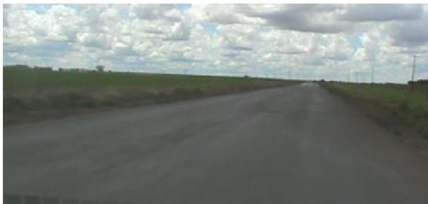
Figura 2: Trecho com pavimento regular e ausência de sinalização horizontal, vertical e de acostamento.
