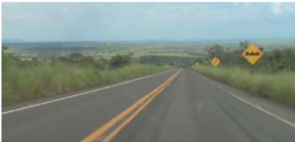
Figura 4: Trecho com pavimento, sinalização horizontal e vertical satisfatórios, com presença de acostamento e proibição de ultrapassagem
