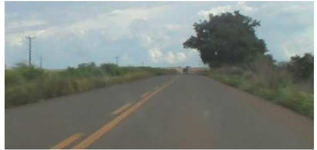
Figura 3: Trecho com pavimento e sinalização horizontal satisfatórios, sem presença de acostamento e permissão de ultrapassagem em um dos sentidos
