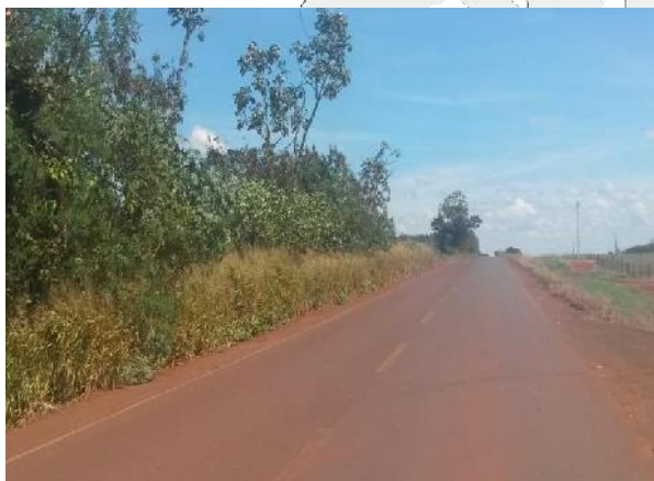
Foto 141 e 142: Visão ampla da rodovia que demonstra ausência sinalização vertical.
