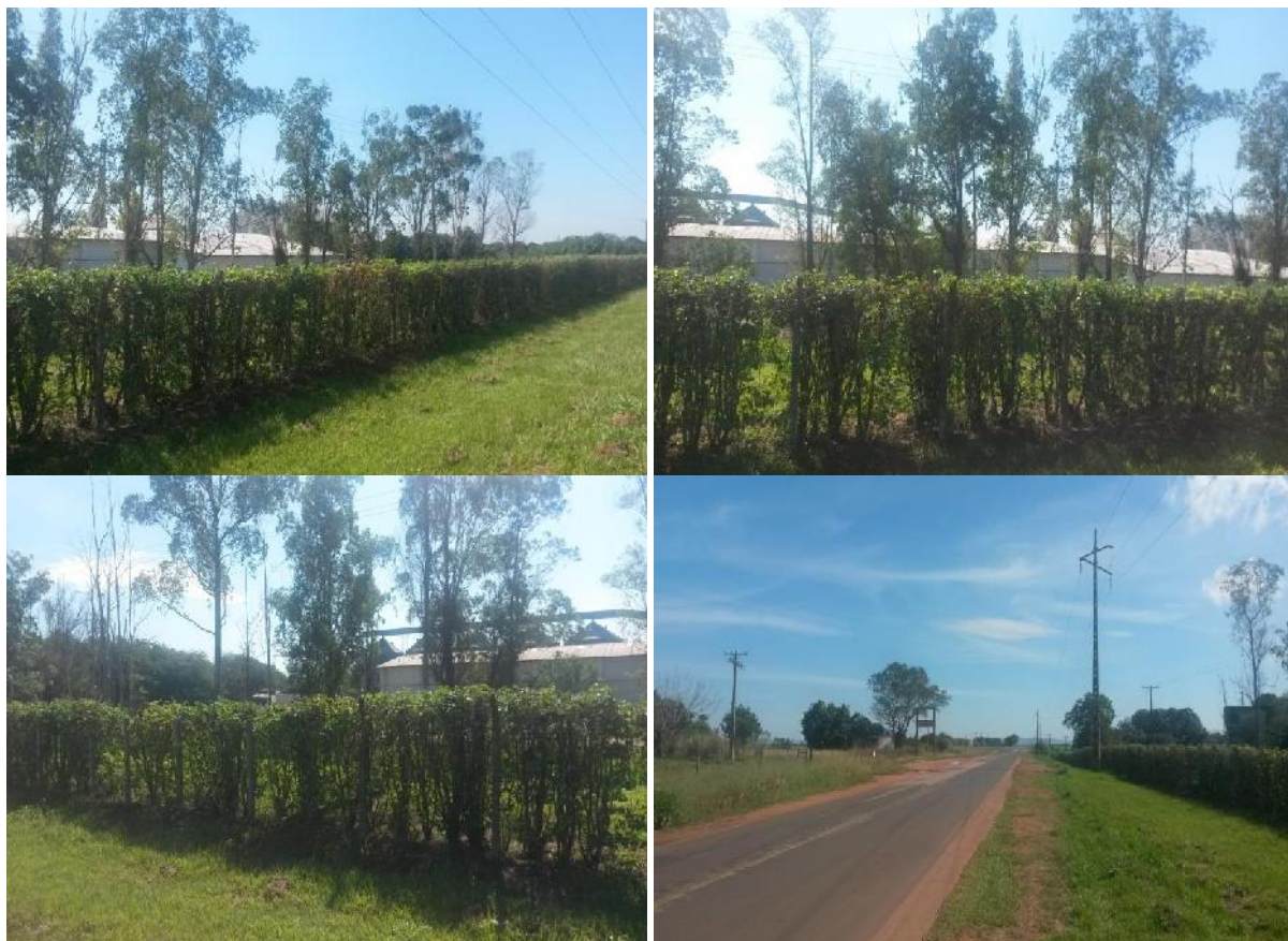
Foto 17 a 20: Silo localizado na faixa de domínio no Distrito Assari do Município de Barra do Bugres - MT 358.
