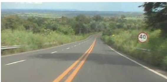
Figura 6: Trecho com pavimento, sinalização horizontal e vertical satisfatórios, sem presença de acostamento, proibição de ultrapassagem e presença de terceira faixa
