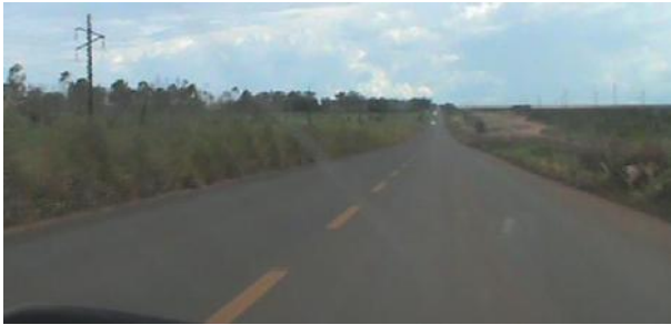
Figura 2: Trecho com pavimento e sinalização horizontal satisfatórias, ausência de acostamento e permissão de ultrapassagem
