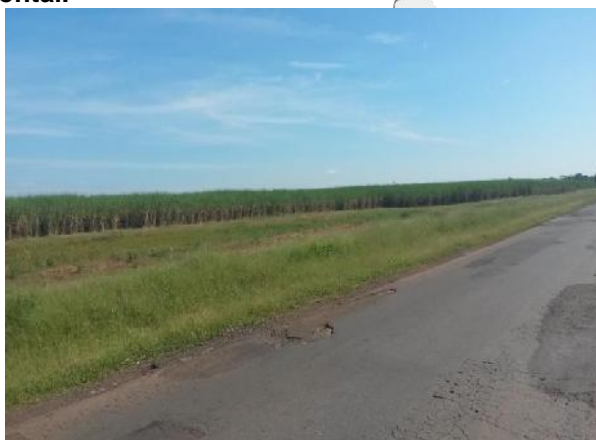
Foto 139 e 140: Visão ampla da rodovia que demonstra ausência sinalização vertical e horizontal.
