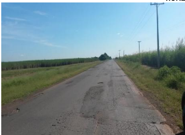
Foto 139 e 140: Visão ampla da rodovia que demonstra ausência sinalização vertical e horizontal.
