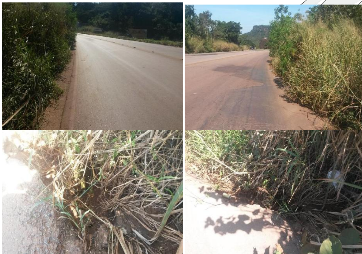
Foto 133 a 136: Km 30,8 a Km 30,29.
