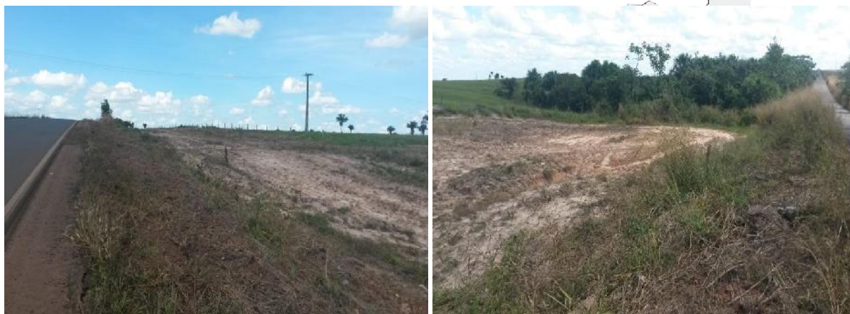
Foto 129 e 130: Km 84,8 a Km 83,40 – AD 5,0 km LD/LE.
