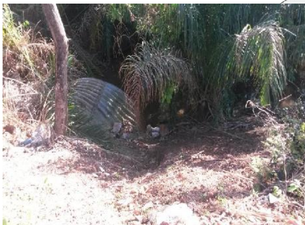
Foto 92 e 93: Bueiro Tubular Simples Armco.
