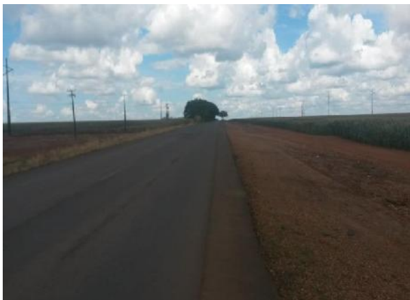
Foto 137 e 138: Visão ampla da rodovia que demonstra ausência sinalização vertical e horizontal.
