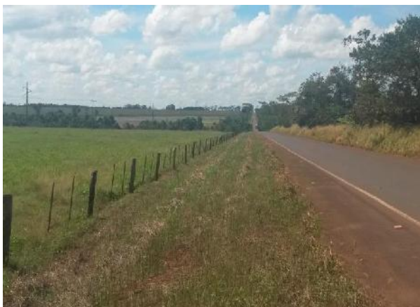
Foto 141 e 142: Visão ampla da rodovia que demonstra ausência sinalização vertical.
